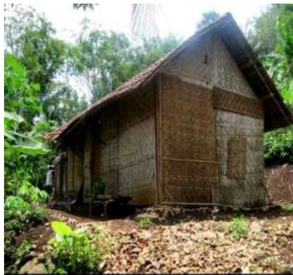
Gambar. 4: Dinding rumah dari Batang Bambu (Obe)
